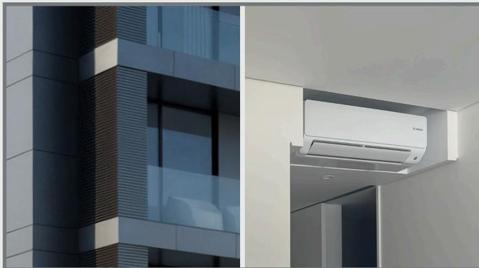
SISTEMA DE AR CONDICIONADO COM UNIDADE EXTERIOR CENTRALIZADA E OCULTA NA FACHADA DA VARANDA, E UNIDADES INTERIORES DE MURAL CUIDADOSAMENTE INTEGRADAS NA DIVISÃO DO APARTAMENTO.
